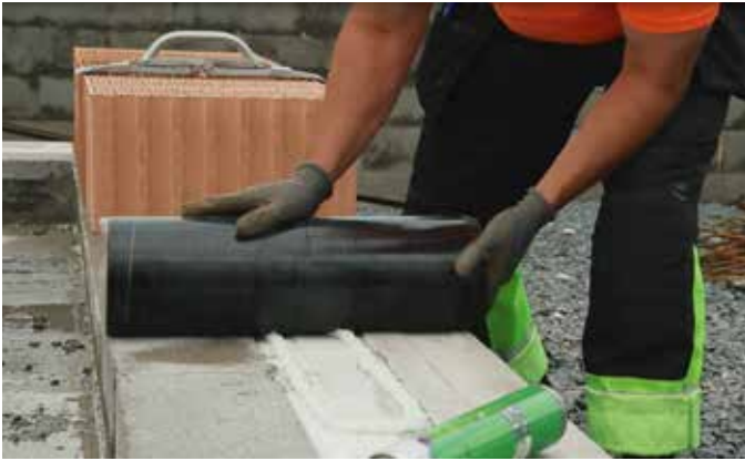
1. Oikaistun sokkelin päälle asetetaan harkkoa leveämpi bitumi-huopakaista, joka toimii kapillaarikatkona.
