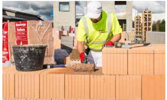
4. Kostutetun harkon pintaan levitetään noin 1 mm ohutsauma-laastikerros esimerkiksi pitkäkarvaisella maalaustelalla.
