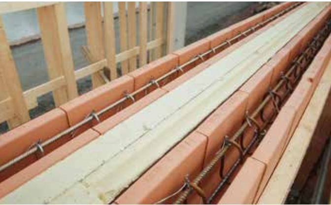
5. Aukkojen ylitykset tehdään U-harkoilla. Raudoitettujen ja betonivalettujen harkkorivien väliin asennetaan eristekerros.
