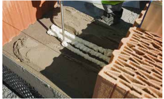
2. Ensimmäinen laastikerros tehdään muurauslaastilla 10 mm vahvuisena, jotta harkkojen aloituskerros saadaan suoraksi.
