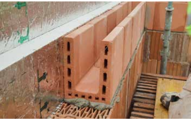
7. U-harkot muurataan eristekerrosta vasten muurauslaastilla. U-harkkojen alle jäävän sauman vahvuus on noin 10 mm.
