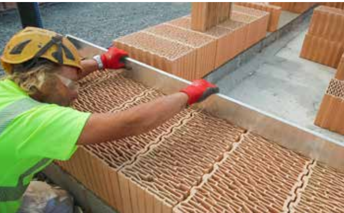
3. Harkot on hiottu korkeudeltaan mittatarcoiksi. Muurauskerrosten suoruus varmistetaan lineaarilla ja vatupassilla.
