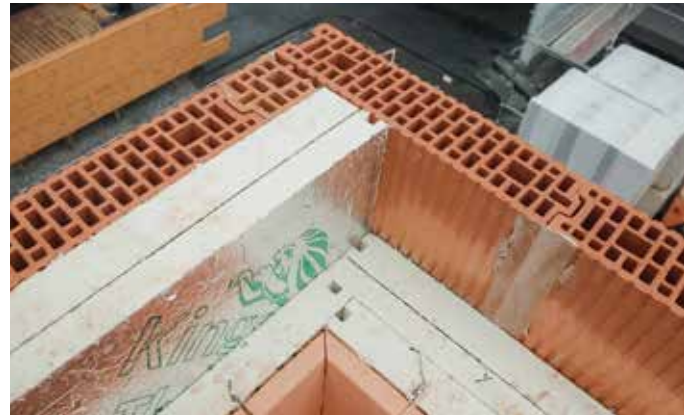
6. Muurauksen saavuttaessa yläpohjatason, asennetaan laastilla suljetun harkkokerroksen päälle maskiharkot ja eristelevyt.
